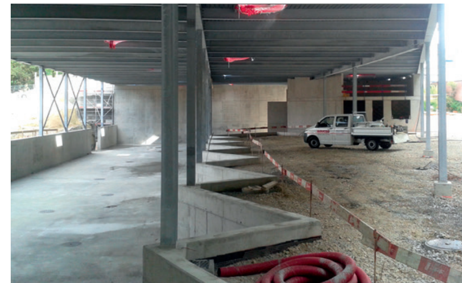
Vue de la nouvelle déchetterie communale, en construction. Chantier suivi par le bureau technique.
