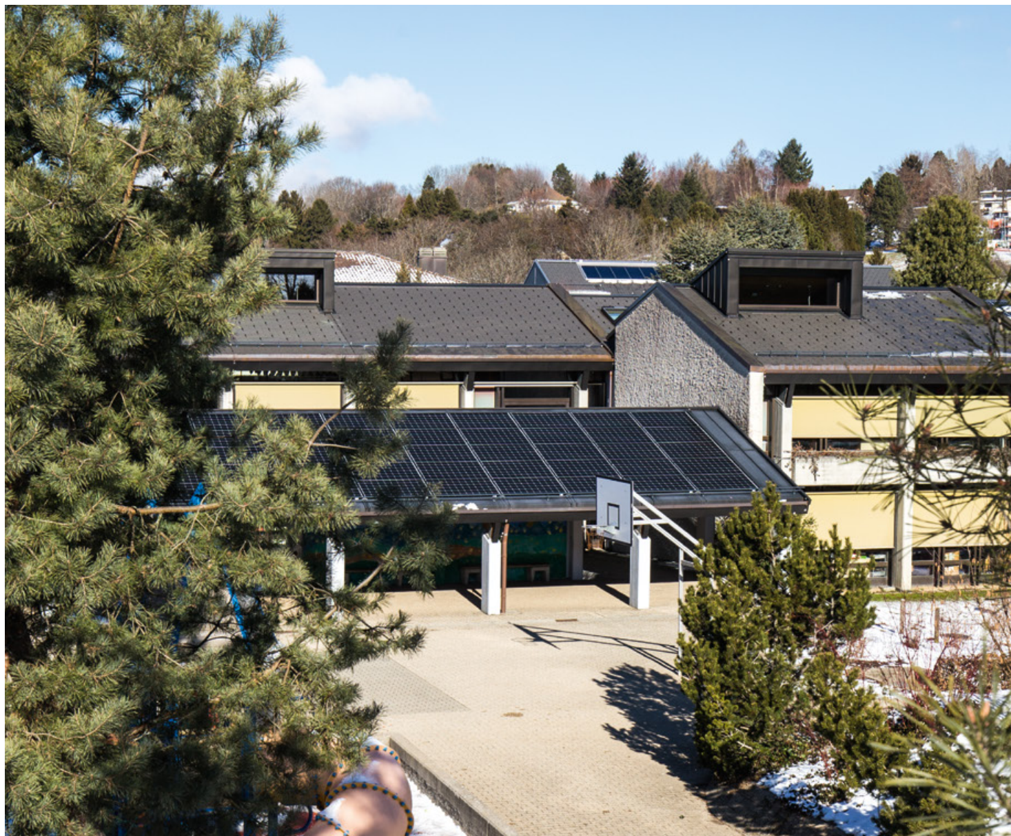
Photo : Panneaux solaires sur le collège de l'Orfèquaz. © Steve Guenat
