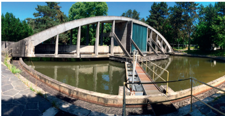
Le bassin de la STEP à Vidy. © Ville de Lausanne - Service de l'eau
