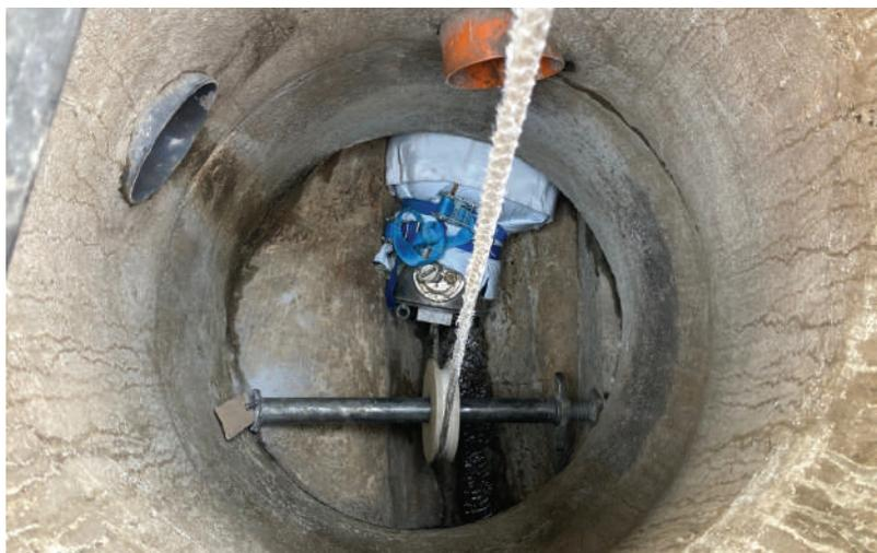
Un collecteur EC endommagé (diamètre 300 mm) a été chemisé sur 47 ml au moyen d'une gaine thermdurcissable en polyester. Cette solution a permis sa réhabilitation sans nécessiter de travaux de fouille sous la route de Berne.
