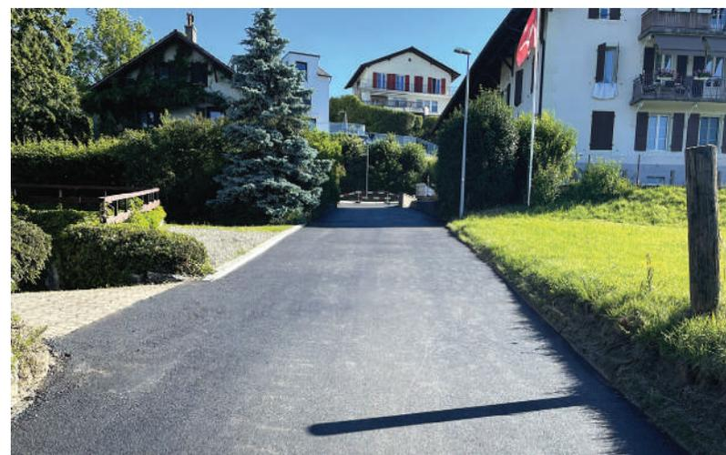
La réfection de la couche de roulement a été réalisée sur une surface d'environ 550 m<sup>2</sup>. Une planche d'essai a été réalisée avec un enrobé bitumineux à basse température, doté d'une teneur en matériaux recyclés plus élevée que la normale.
