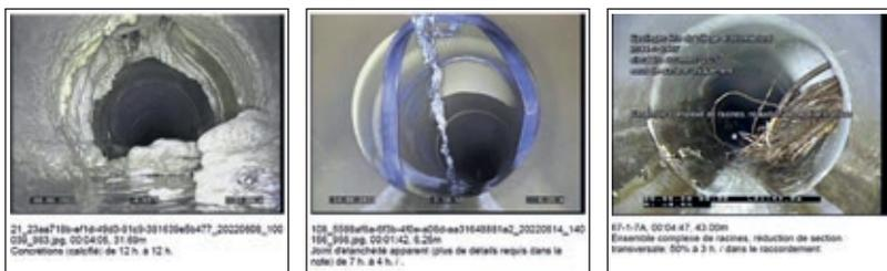
Types de problème détecté obstruant l'écoulement : présence de calcaire, joint visible ou présence de racines
