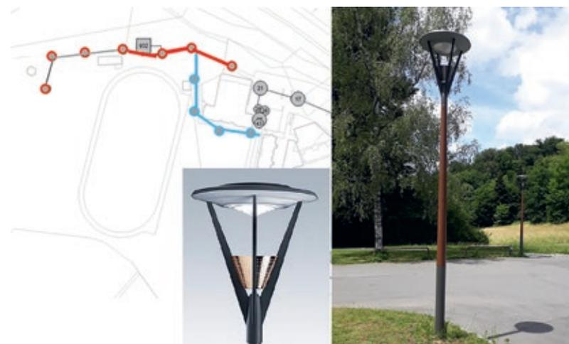
La température de couleur retenue de 2700 K diminue les impacts sur la faune sauvage à proximité de la forêt. Au niveau énergétique, la consommation annuelle passera d'environ 4189 kWh à 230 kWh, soit une économie estimée de 3959 kWh par année.
