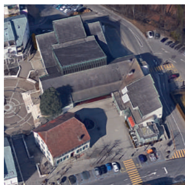
Administration communale et grande salle; Collège de Bois-Murat.
