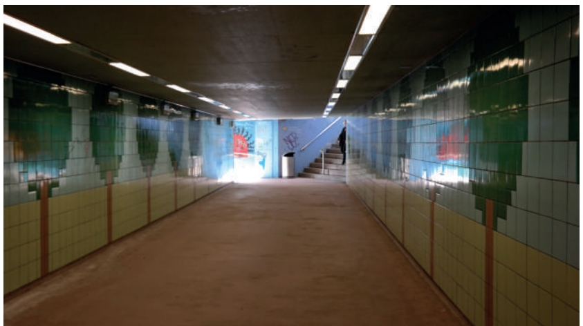
Passage sous-voie à la route de Berne.
