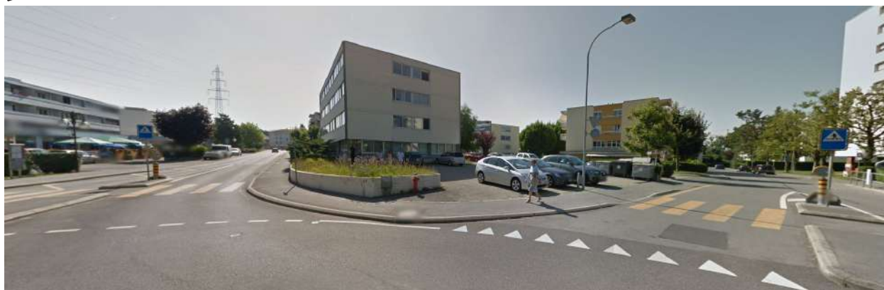
Plots à l'angle nord-ouest, unité des gabarits, espaces extérieurs colonisés par la voiture
