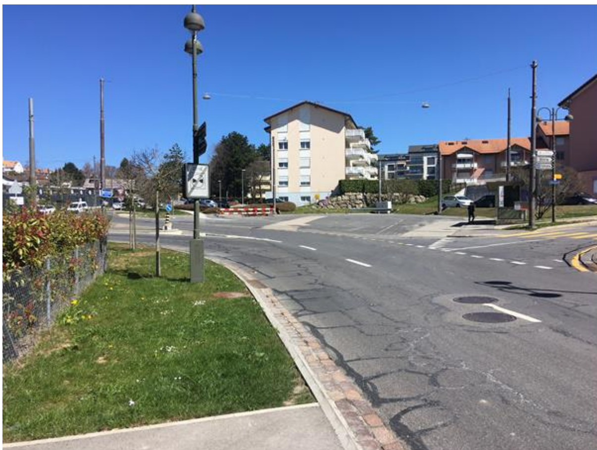
Rte de la Croix-Blanche, ancien terminus de la ligne TL 5, les parcelles RF 532 & 590
