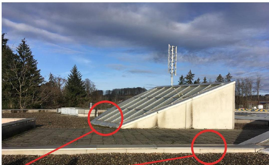
surélévation de la remontée d'acrotère pour dégager le joint de dilatation
