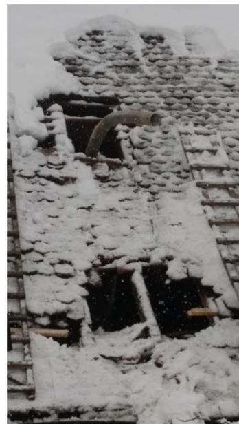
La toiture arrière en automne 2018 et les dégâts de l'hiver 2018, réparés provisoirement depuis.
