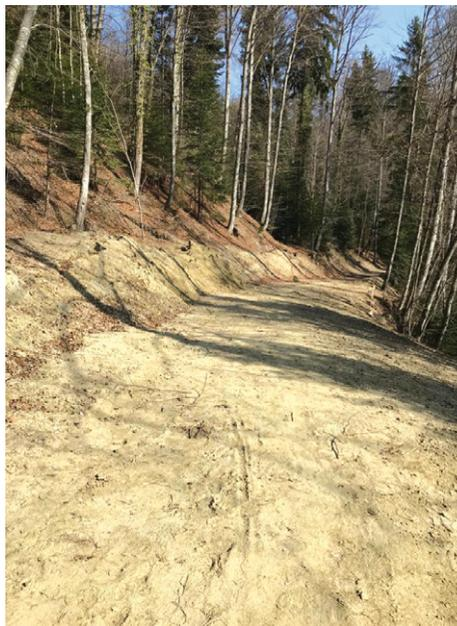
praticable. Pour garantir une bonne stabilité, le nouveau passage a été aménagé sur ces 60 premiers mètres un peu plus en amont que le chemin existant afin de s'éloigner de la pente abrupte. À l'endroit du glissement de terrain constaté, des travaux de lissage du talus ainsi que la pose de tuyaux d'écoulement ont été entrepris.
