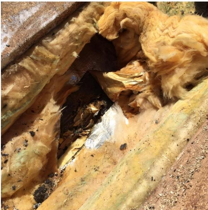
Moisissures et infiltrations sur la sous-couverture
