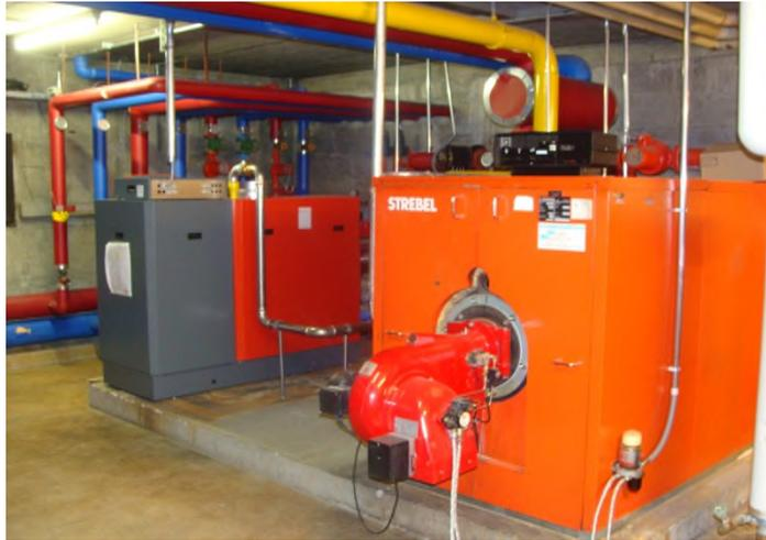
Figure 1 Chaudière à gaz N° 2 à gauche et chaudière N° 1 à mazout à droite
