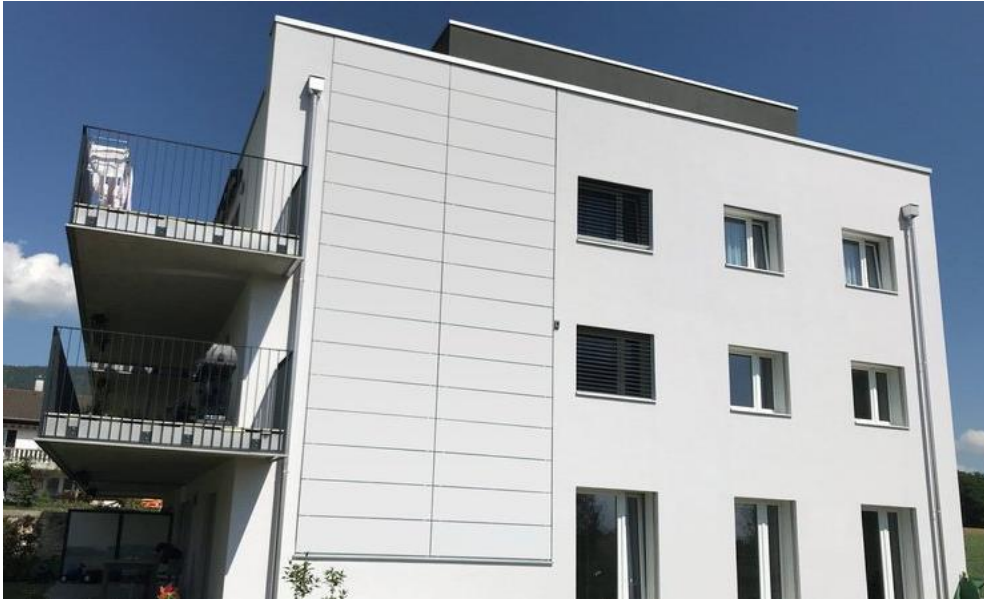
Immeuble à Boudry (NE) de Solaxess
