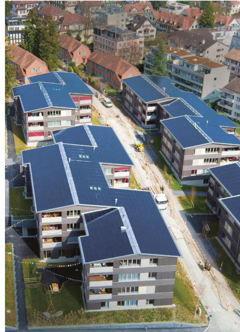
Lotissement de la Balberstrasse © Suntechnics Fabrisolar AG
