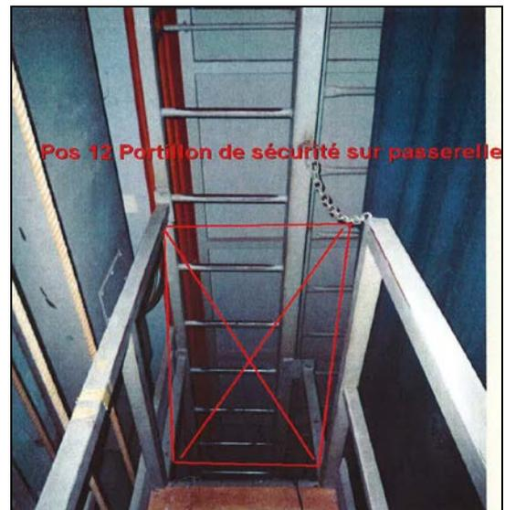
Sur les passerelles destinées à la manipulation des décors et de l'éclairage, les normes actuelles de sécurité ne sont plus respectées. Il est indispensable de poser des portillons avec fermeture automatique, afin de sécuriser ces passerelles sur lesquelles le personnel de scène et le concierge se déplacent dans l'obscurité.
