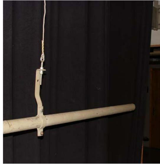
Lors du remplacement des câbles en acier (voir le point « câbles de tirage » ci-dessus), il est préconisé de remplacer les barres d'éclairages (actuels tubes de 40 mm de diamètre) par des perches doubles d'un diamètre de 48,3 mm en forme d'échelle. Ainsi, des projecteurs actuels tels que les projecteurs motorisés pourront être suspendus sans risque.
