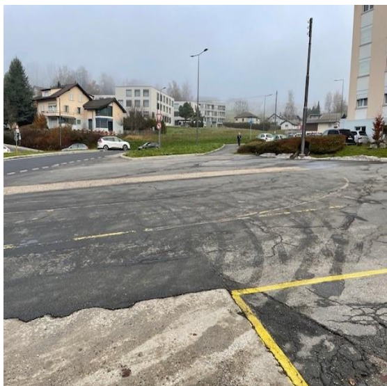
Ancien terminus du bus 5 (arrêt Giziaux, une fois les travaux réalisés)
