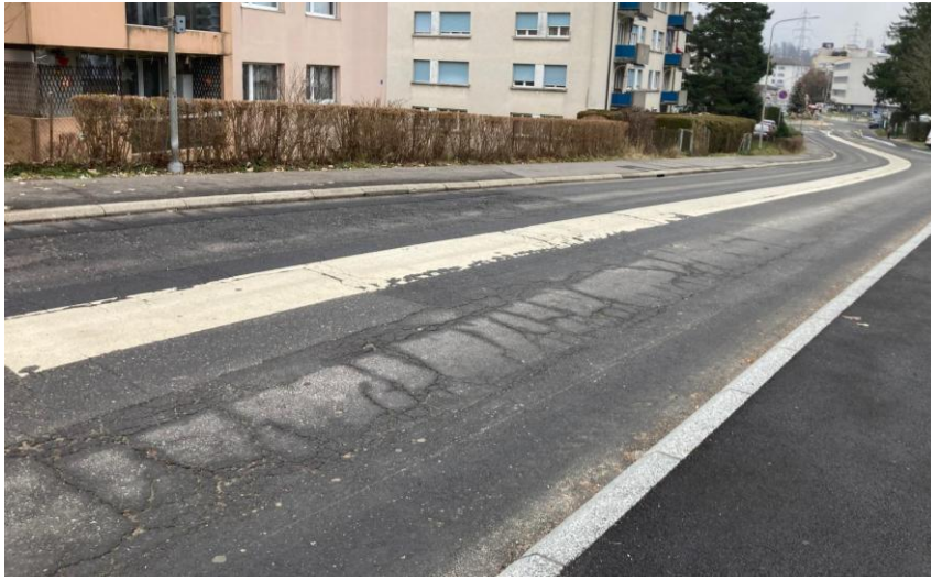
Photo 1 – Chemin des Tuileries - Zone Est
