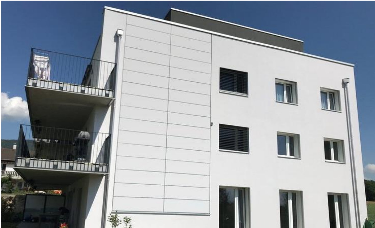
Immeuble à Boudry (NE) de Solaxess
