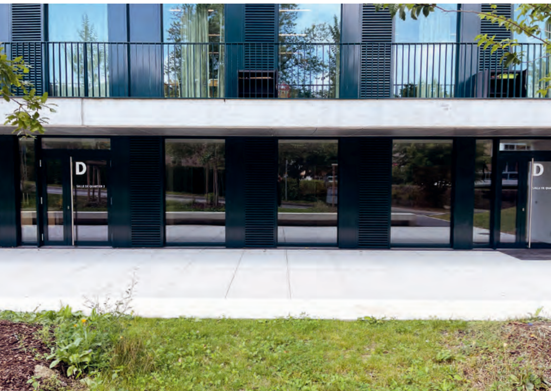
Salles de quartier du collège de Bois-Murat
